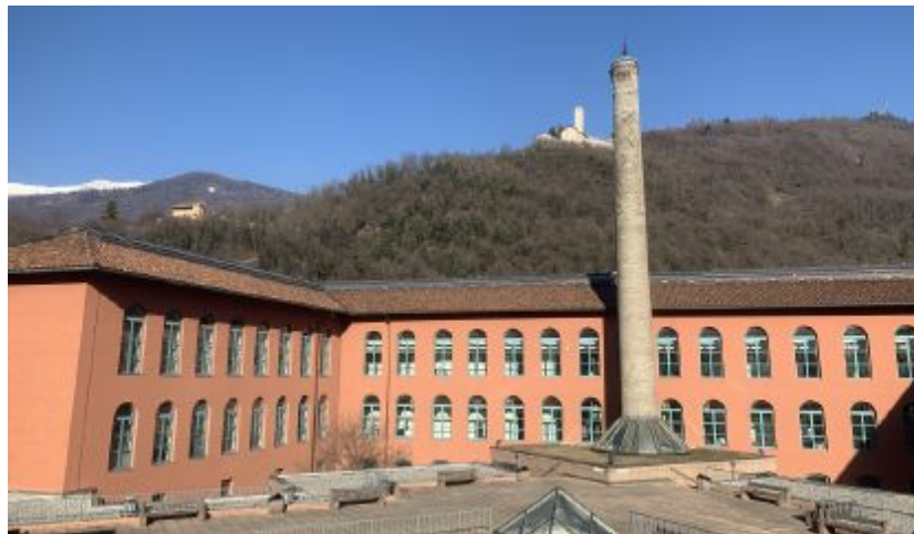
Superiore L'Istituto Degasperì ha sede nell'edificio dell'ex filanda
